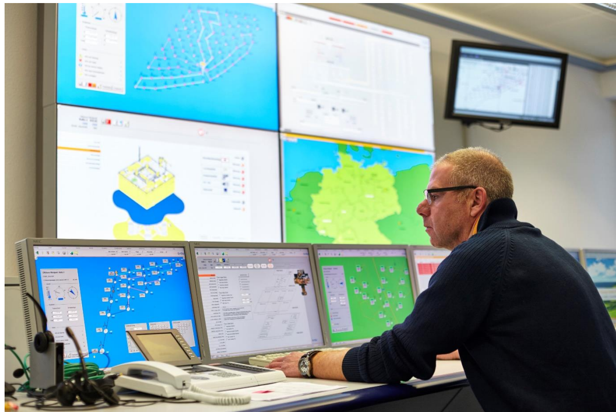
Figure 6: Conduite opérationnelle des installations de production au sein du Centre d'Exploitation de Barhöft
